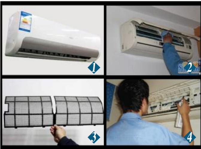
**STEP 1** 清洗空调外机。打开空调盖,用湿抹布擦拭裸露在外部的机壳,在细节与连接处要多加留心,防止死角上灰尘的残余。重点要清理空调出风口的导风页,在长期的使用中,空调出风处表面极易积压灰尘。
